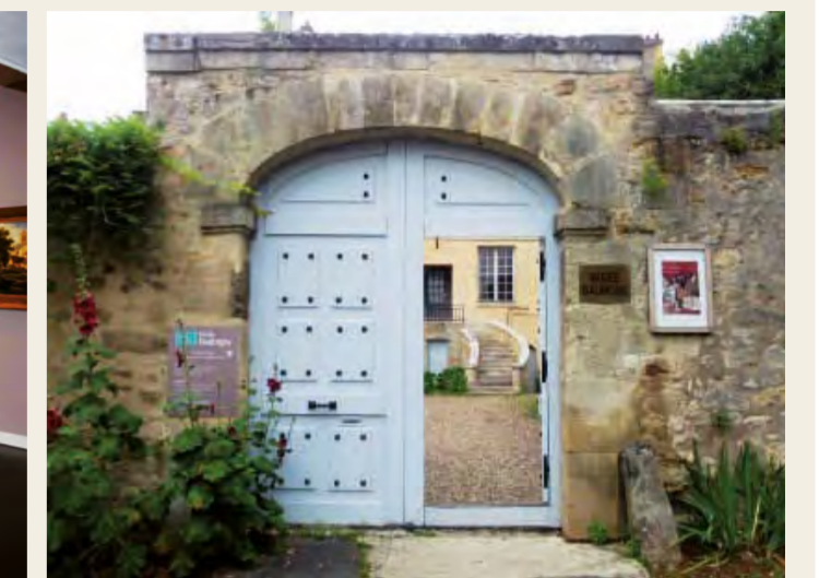
Les menuiseries extérieures ont été entièrement repeintes.
